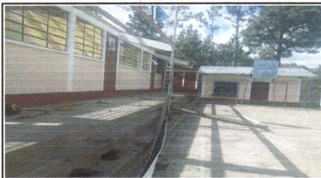
FOTO 4 Las canaletas son estan siendo cambiadas
