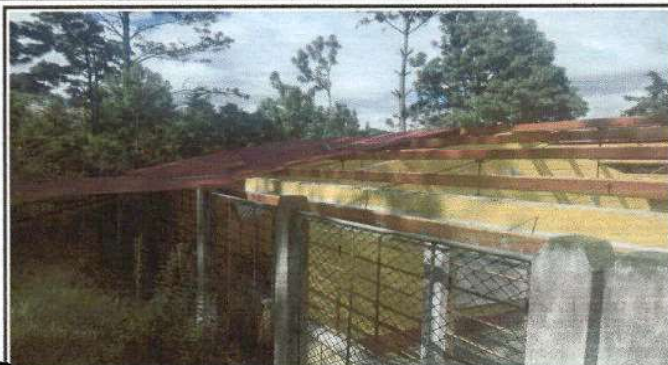
FOTO 1 La lamina antigua del techado ha sido desistalado.
