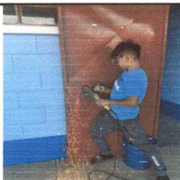
FOTO 5 Desinstalación de tres chapas viejas.
