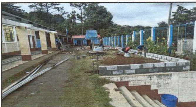
FOTO 3 Avance del muro perimetral del patio y jardin a mejorar.
