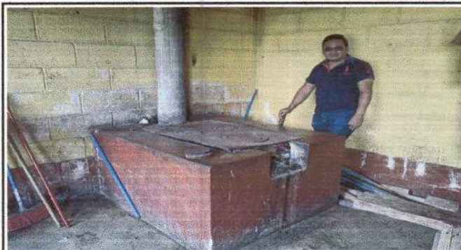
FOTO 2 La plancha se esta remobiendo.
